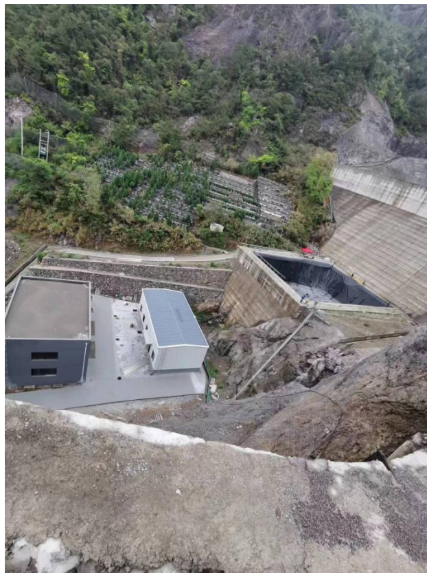
调节池及渗滤液污水处理站
